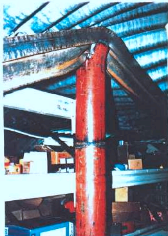
'n Staalstut wat geswig het onder die kwaai druk van die ys
