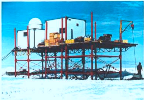
Die ho-luggebou nadat die stellasie opgehys is en die ballonkamer afgetakel is
