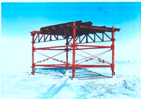
Die stellasië wat in gereedheid gebring was om die satellietskottel te huisves
