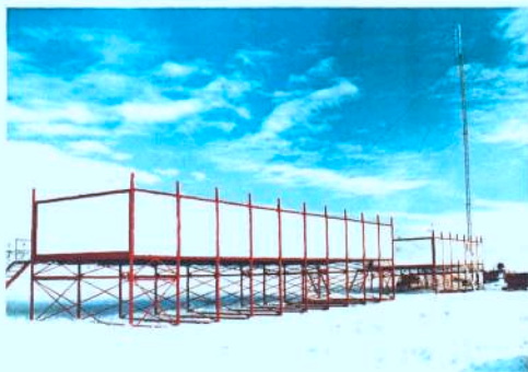
Vesleskarvet konstruksiebasis. Merk die min sneeu-opbouing onder die basis op
