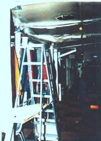
Beskadigde plafon as gevolg van die drukking op die basis.
