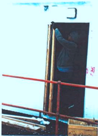
DOW lid besig om 'n deur te vervang nadat dit in sy geheel deur die stormwind uitgewaai was
