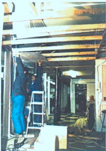
DOW spanlede in die proses om vals plafon te installeer.
