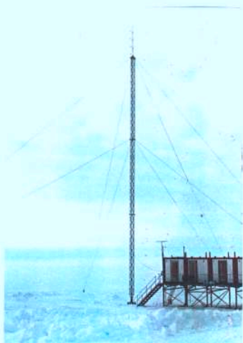
Die 30 meter hoë BHF mas wat op Vesleskarvet opgerig was
